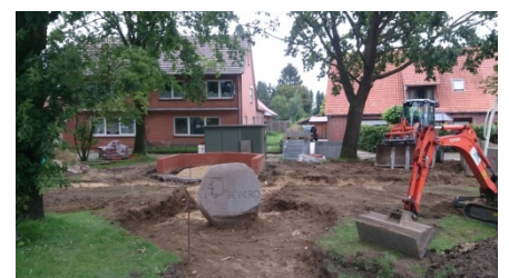
Noch ist die Baustelle groß „Am Brink“
